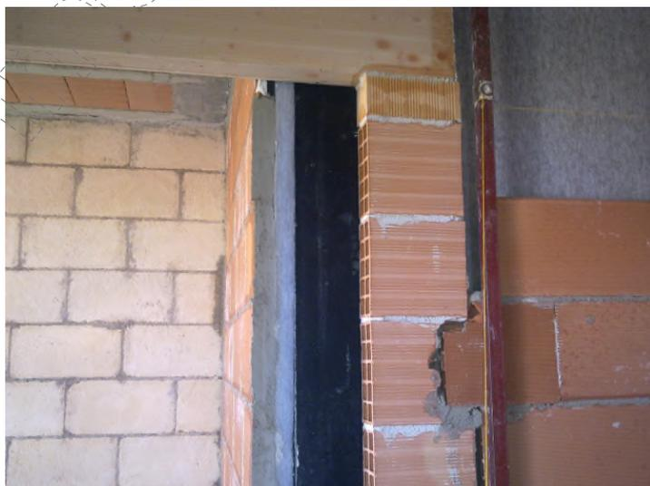
barriera al vapore per evitare formazione di condensa all'interno della muratura
